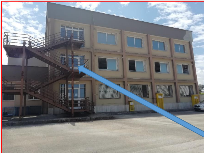
PORTA DI ACCESSO PIANO RIALZATO
